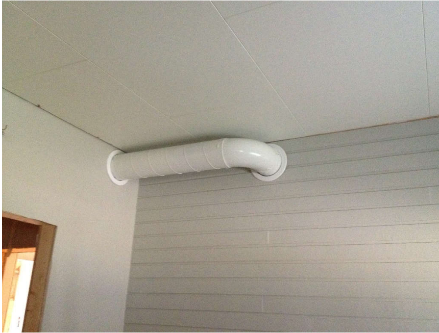
2014-09-12. Det synliga ventilationsröret i herrarnas omklädningsrum är nu målat
