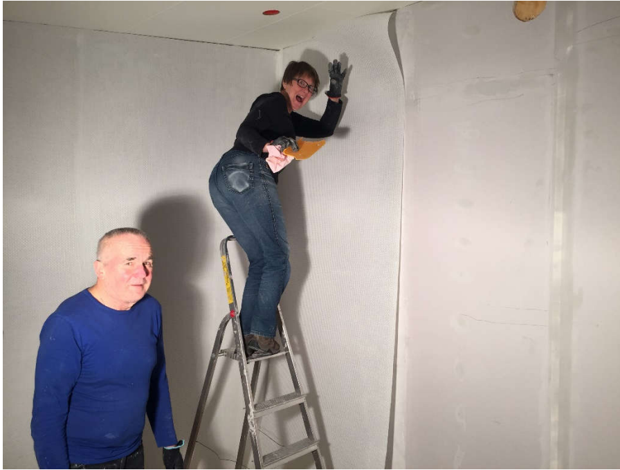
2015-02-02. Helena och Ove tapetserar datarum och allrummet på övervåningen
