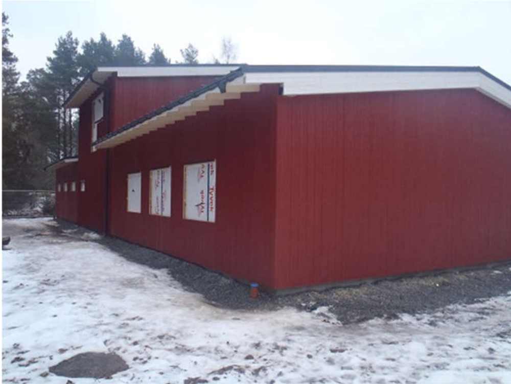
2014-02-04. Baksidan från nordvästra hörnet
