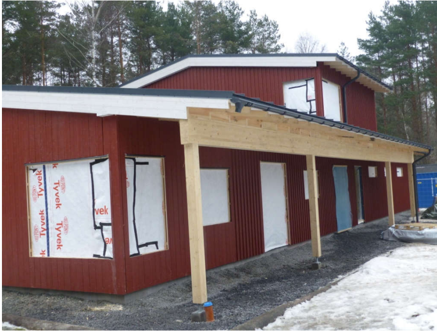
2014-02-06. Lockpanelen är nu i stort sett på plats.
