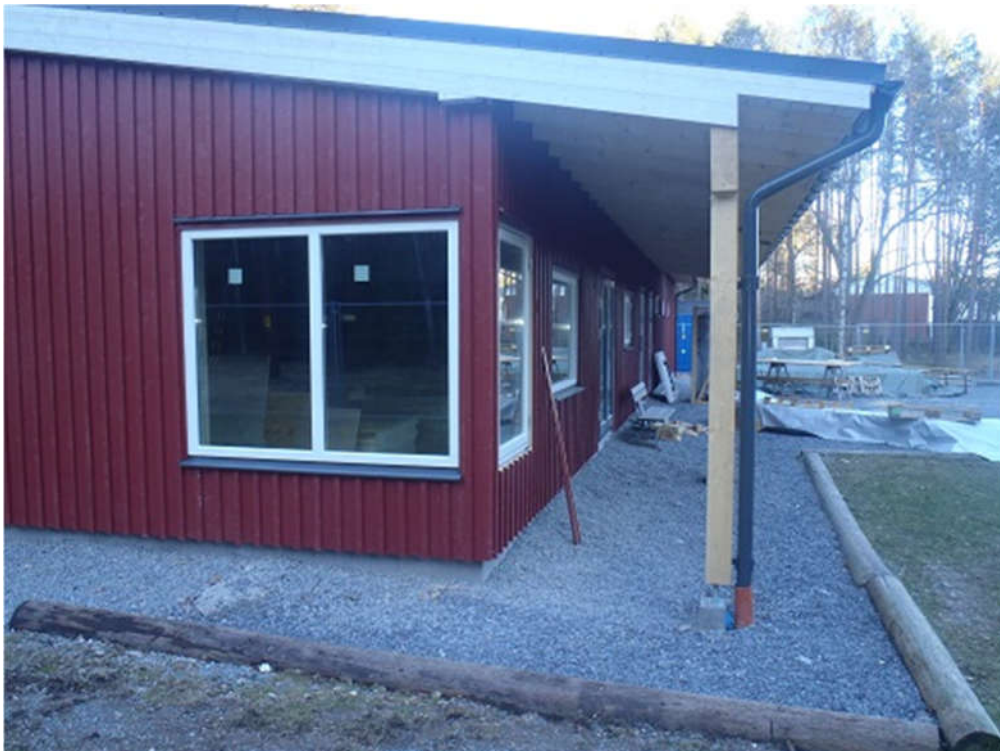
2014-03-23. Så här blir ytterhörnet med hörnfönstren på plats.
