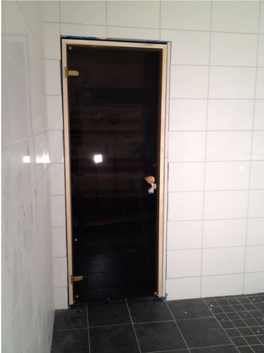
2014-12-01. Här är dörren in till herrarnas bastu. Även dambastun har fått dörr idag
