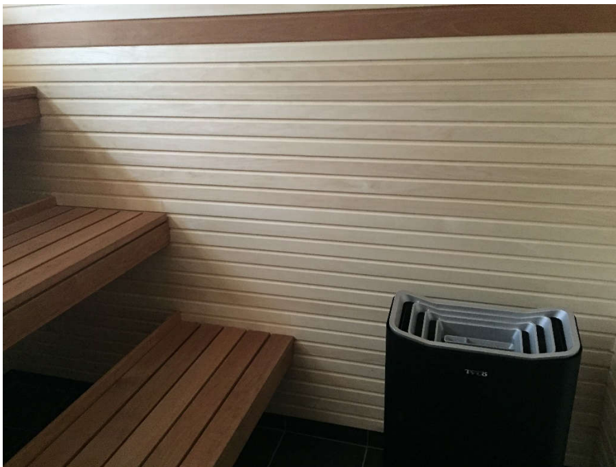
2015-02-02. Dambastun i det närmaste klar. Återstår bara skydd runt bastuaggregatet nu.
