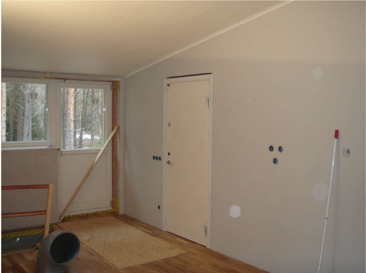
2015-02-27. Samtliga dörrar och lister på plats på övervåningen. Här ser vi säkerhetsdörren in till kontoret.
