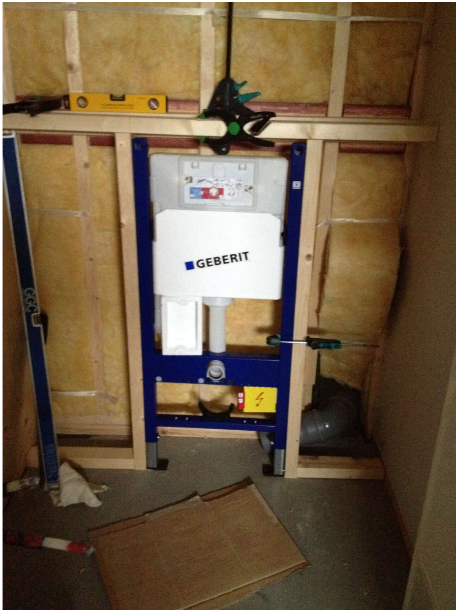
2014-09-10. Monteringen av vattenkassetterna till de vägghängda toaletterna provas ut av Hans
