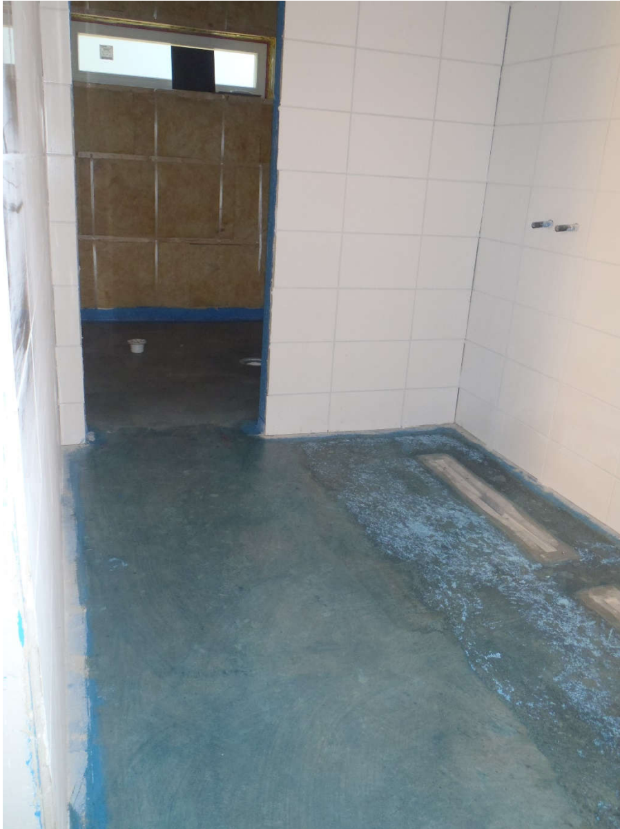
2014-09-27. Golvet i båda duscharna primat med våtskydd och ska nu bara täckas två gånger med tätningsmassa för att sedan täckas med klinkers
