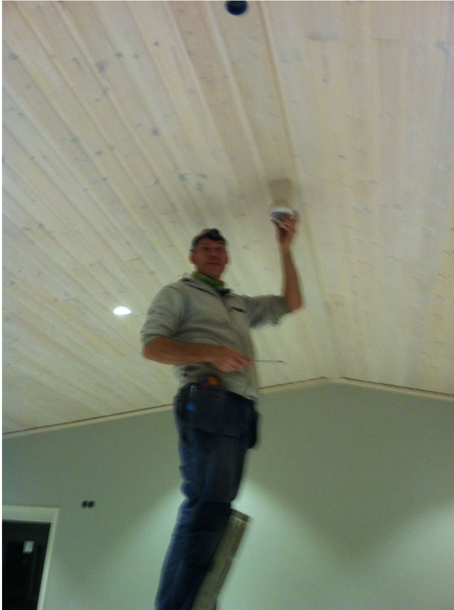
2015-11-12. Montering av larm slutförd. Här sätter Per upp brandlarm? i taket i storstugan.
