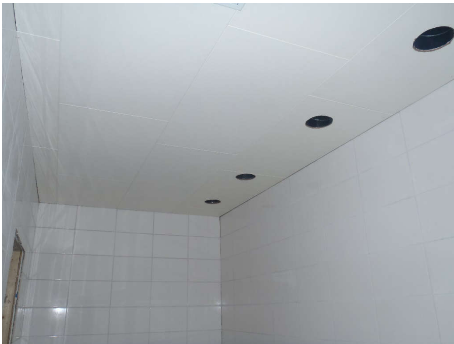
2014-09-24. I damduschen har alla skivor redan monterats i taket
