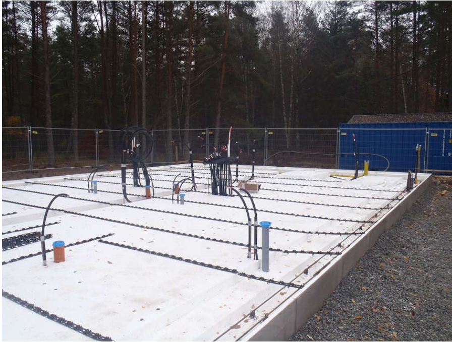
2013-11-02. Här har vår plattbyggare Joakim gjort isoleringen klar. Vi ser också fästskenorna för golvvärmerören.
