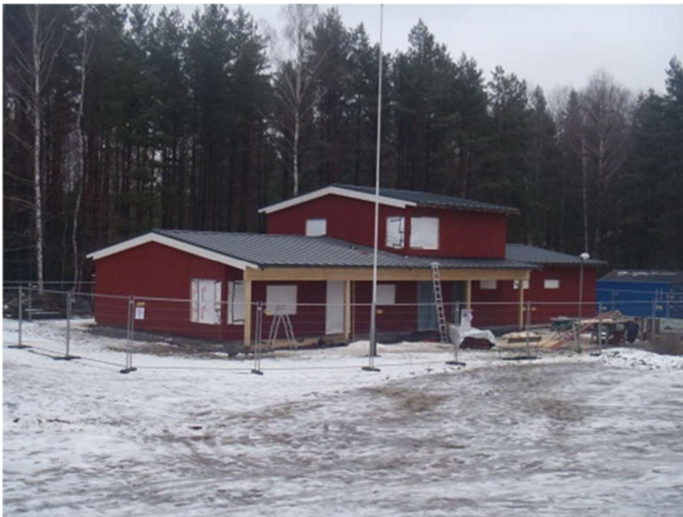
2014-02-04. Alla paneler på plats, fattas bara lockpanel. Nu kan man verkligen se hur stugan kommer att se ut. Idag bytte man också stödet till pelarna på framsidan då de som suttit där tidigare var lite klena.
