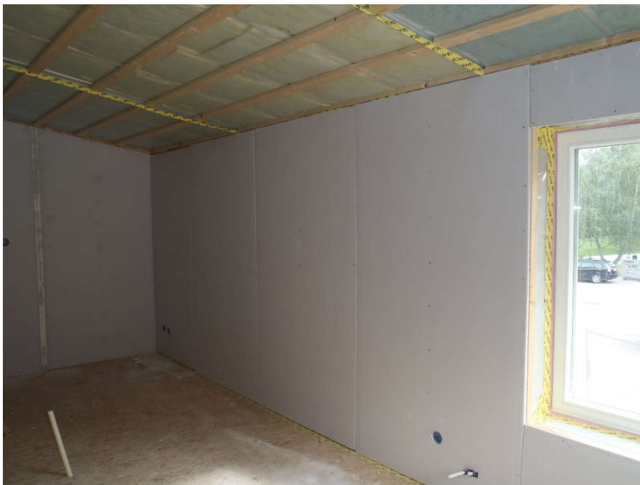
2014-08-10. Mötesrummet på övervåningen har börjat kläs med gips på väggarna
