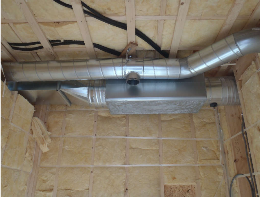
2014-09-27. Ventilationstrummorna nu dragna igenom WC för att fortsätta in i köket och allrummet
