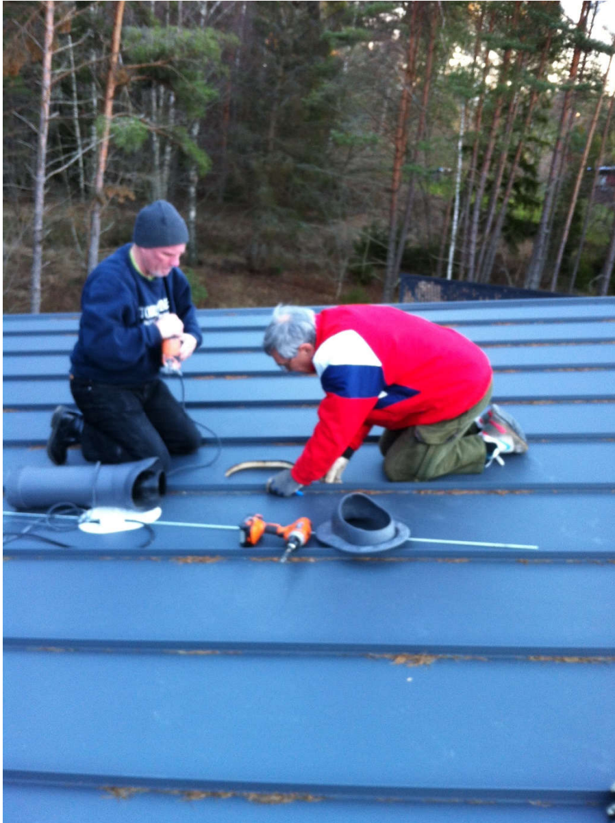
2015-01-03. Hans och Roland monterar takstos för avloppsventilation på översta taket.
