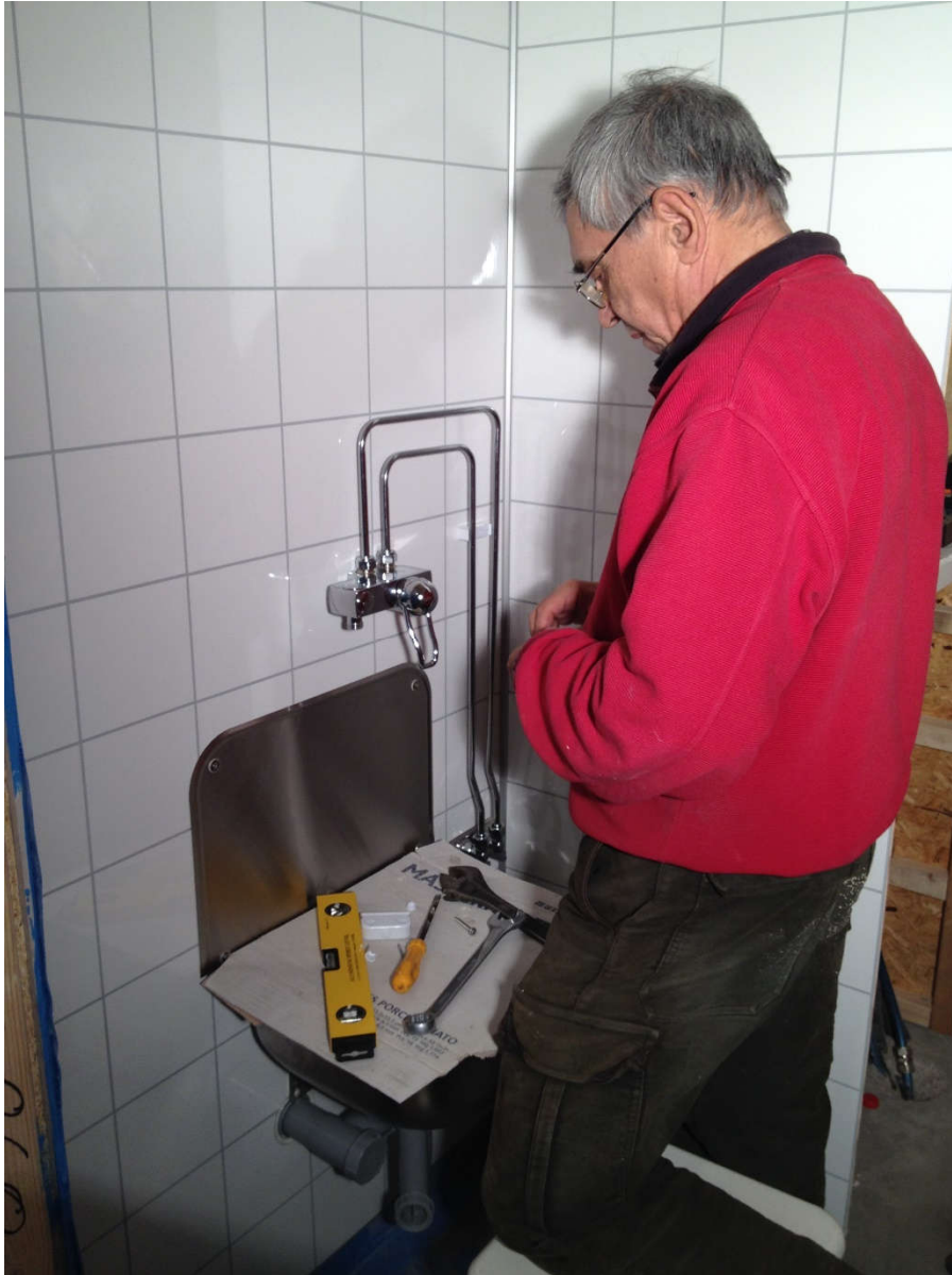
2014-11-25. Hans monterar vattenrör till kran i städskrubben
