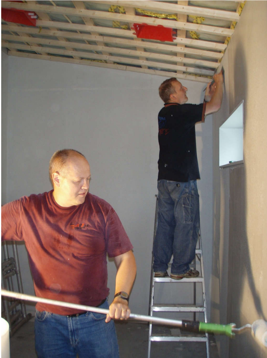
2014-06-29. Tapetseringen av väggarna i omklädningsrummen gjordes i helgen. Här ser vi Ulf och Johan i arbete
