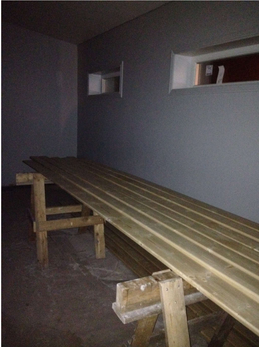
2014-12-01. Här ligger brädor som ska användas till bänkar i omklädningsrummen på tork efter slip och lack
