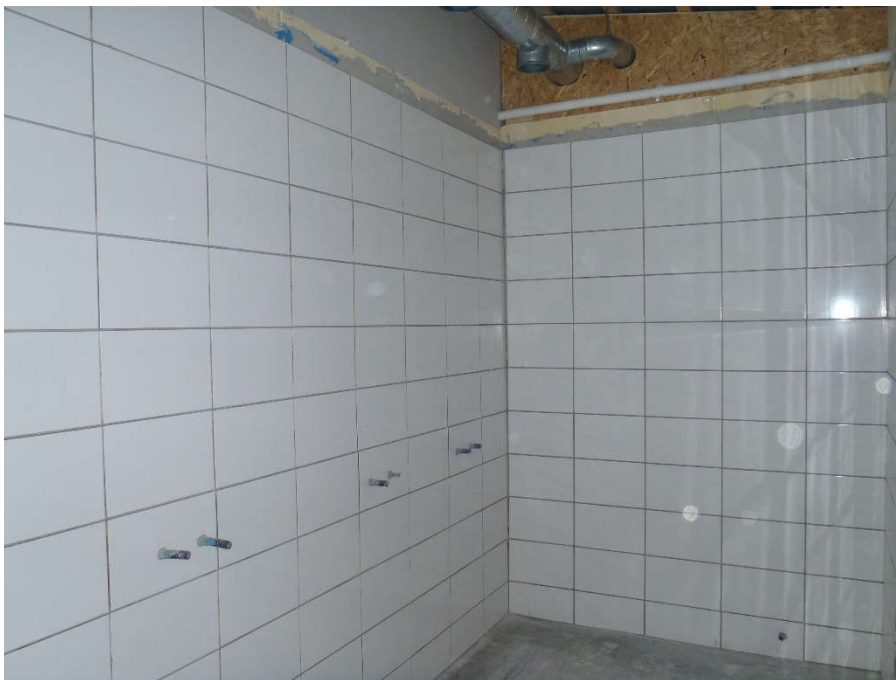
2014-08-30. Kakelsättningen i herrarnas dusch är nu helt klar. Återstår bara fogning
