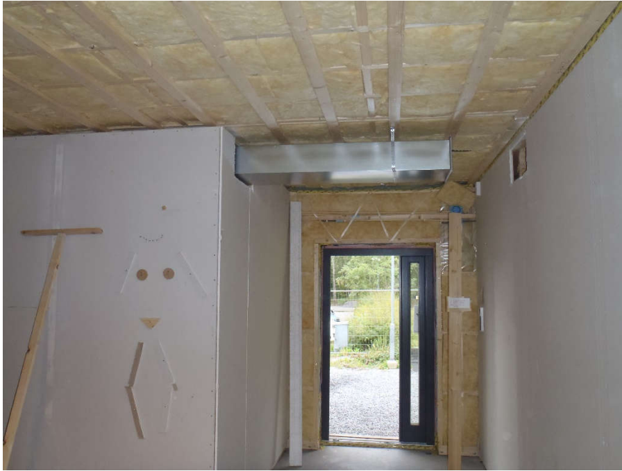
2014-08-30. Den rektangulära ventilationskanalen börjar komma på plats. Håltagningen till köket är klar
