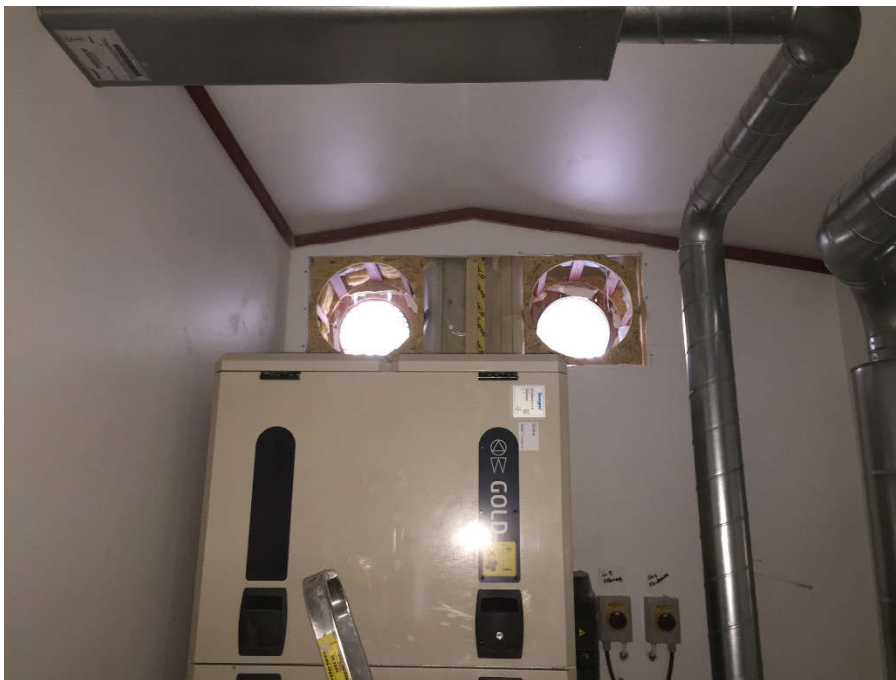
2015-04-04. Håltagning efter det att hålet flyttats
