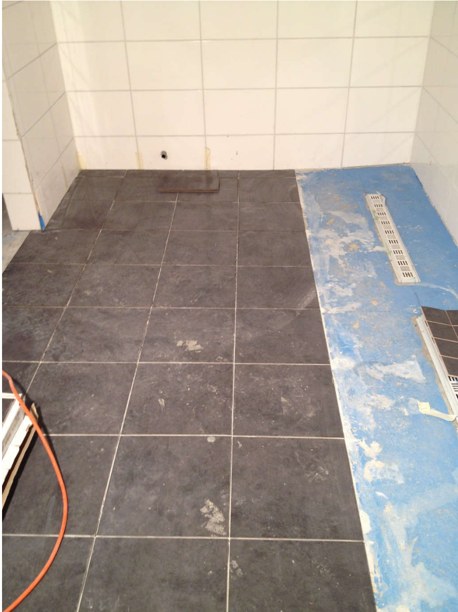
2014-10-17. Klinkersättning i damernas dusch
