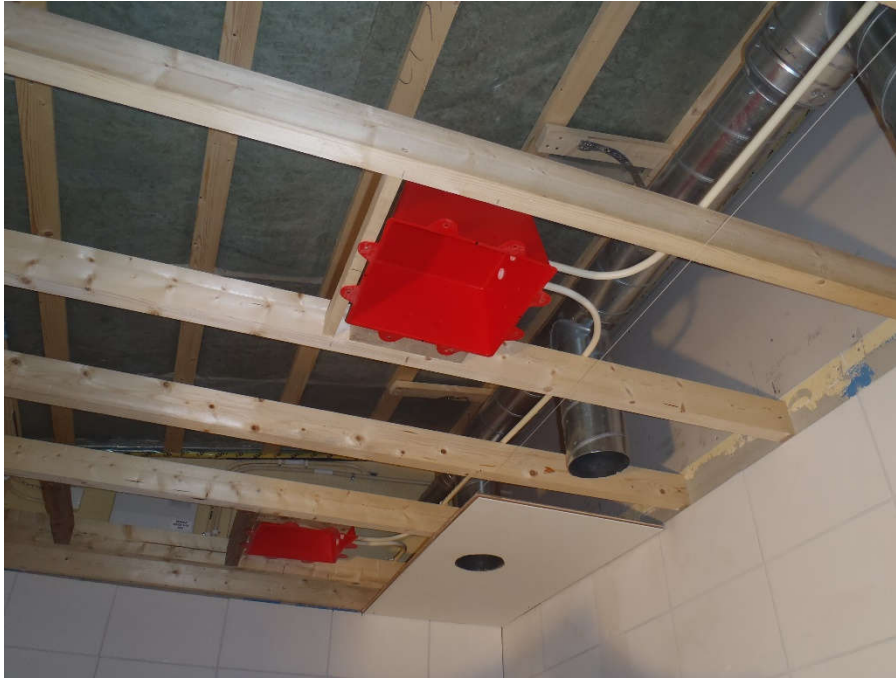
2014-09-24. Montering av takskivor i herrduschen har påbörjats
