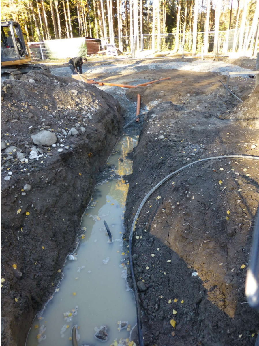
2013-10-18 14.06. Nya avloppsrör med ny rensbrunn ansluts till kommunens avloppsnät.
