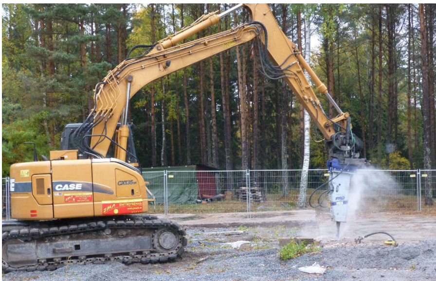
2013-10-09 08.47. Knacken går igång för att ta bort den gamla plattan och bereda plats för vår nya stuga.
