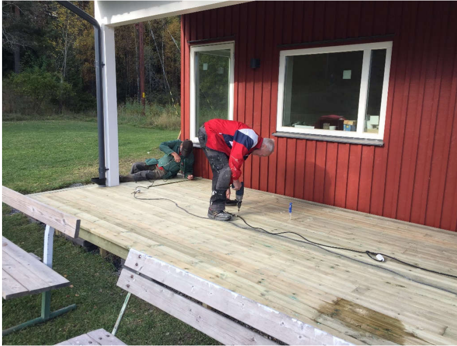
2015-10-06. Altanbygget på väg att bli klart. Uffe och Bosse skruvar, Uno och B-O har också byggt.
