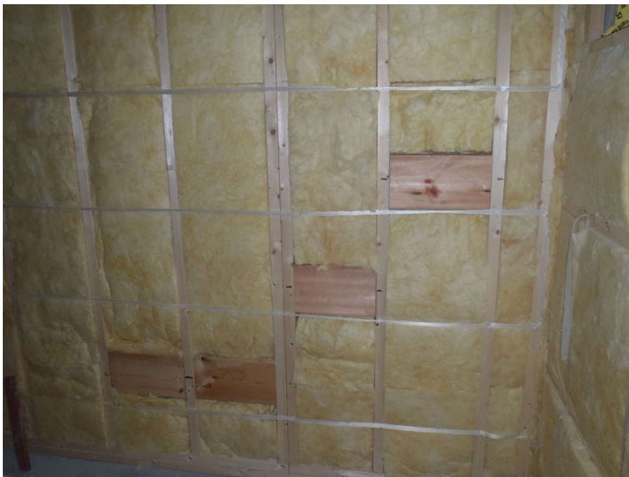
2014-08-30. Kottlingar för bastulavarna på plats. Nu är det dags för panel i båda bastuna
