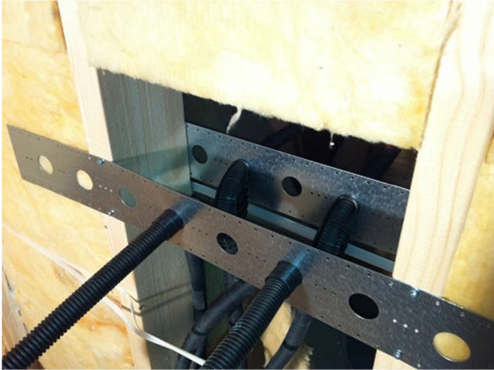
2014-04-05. Vattenrören monteras hela vägen för att uppfylla Säker vatten installation. Plåtarna ger automatiskt 160 c/c för att passa till duschblandaren.
