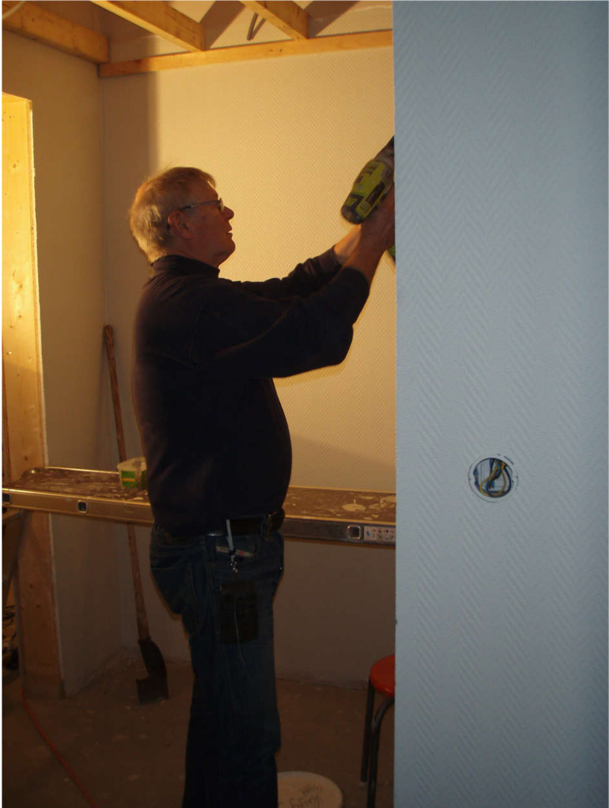
2014-10-26. Lars-Göran arbetar med att montera takreglar
