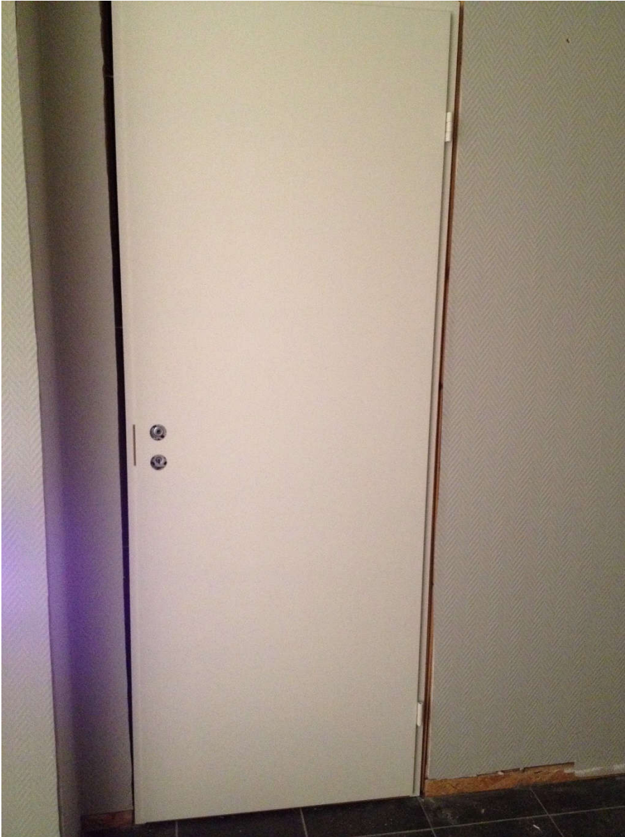
2014-12-01. Första dörrarna på plats, den här går till toaletten i herrarnas omklädningsrum
