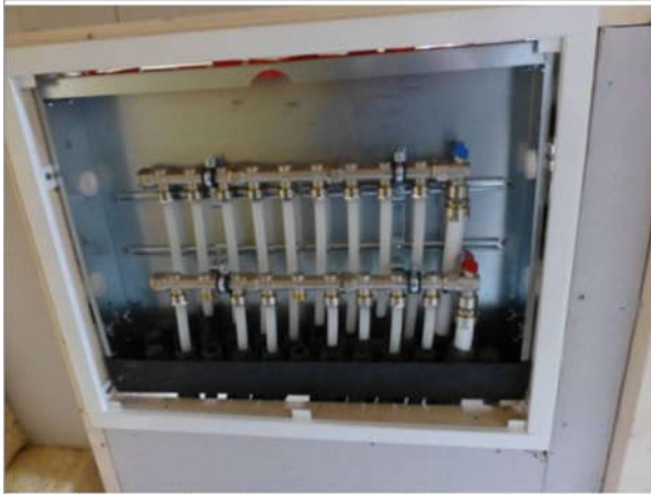
Fördelarna för kall- och varmvatten för hela huset sitter i toaletterna i herrarnas (vänstra bilden) och damernas (högra bilden) omklädningsrum. De kommer att döljas av en vitmaljerad lucka.
