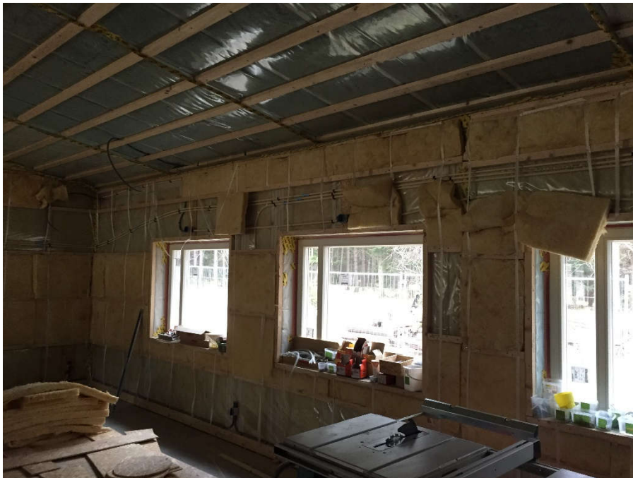
2015-04-04. Här har elektrikerna påbörjat installationen i storstugan
