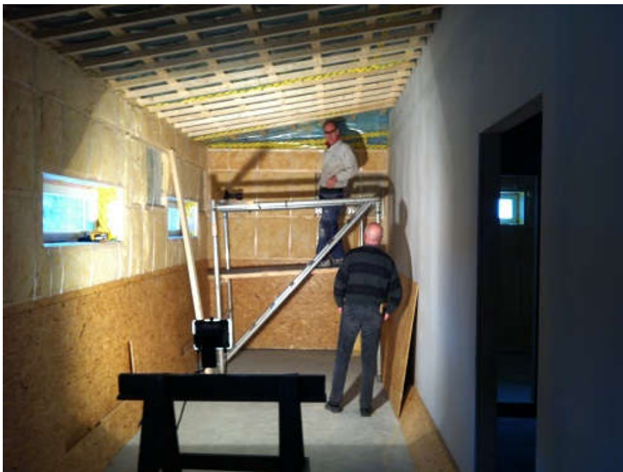
2014-03-14. B-O och Cobran i färd med att montera läkt i taket på herrarnas omklädningsrum.
