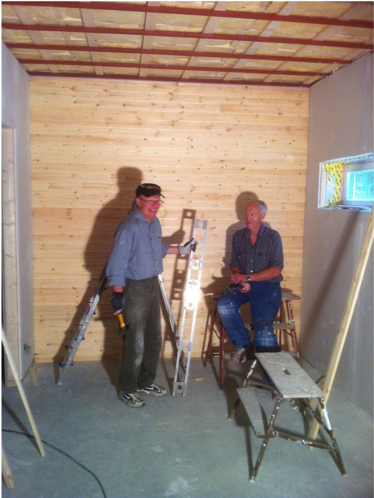
2014-06-17. Här har snickarna fått upp en av brädväggarna som kommer att finnas i båda omklädningsrummen. Den som syns på bilden hör hemma i herrarnas omklädningsrum och kommer att målas skogsgrön.
