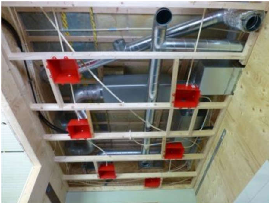
2015-07-15. Installationerna i kökstaket klara: Ventilationsrör, imkanal, elledningar och "lamppottor". (Bilden tagen rakt upp från golvet).
