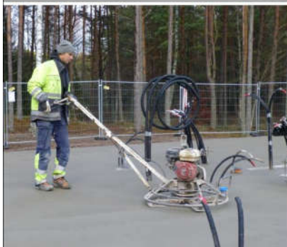
Ovan formas fallen mot avloppsrännorna i de blivande duschrummen och till vänster avjämnas plattan efter gjutning
