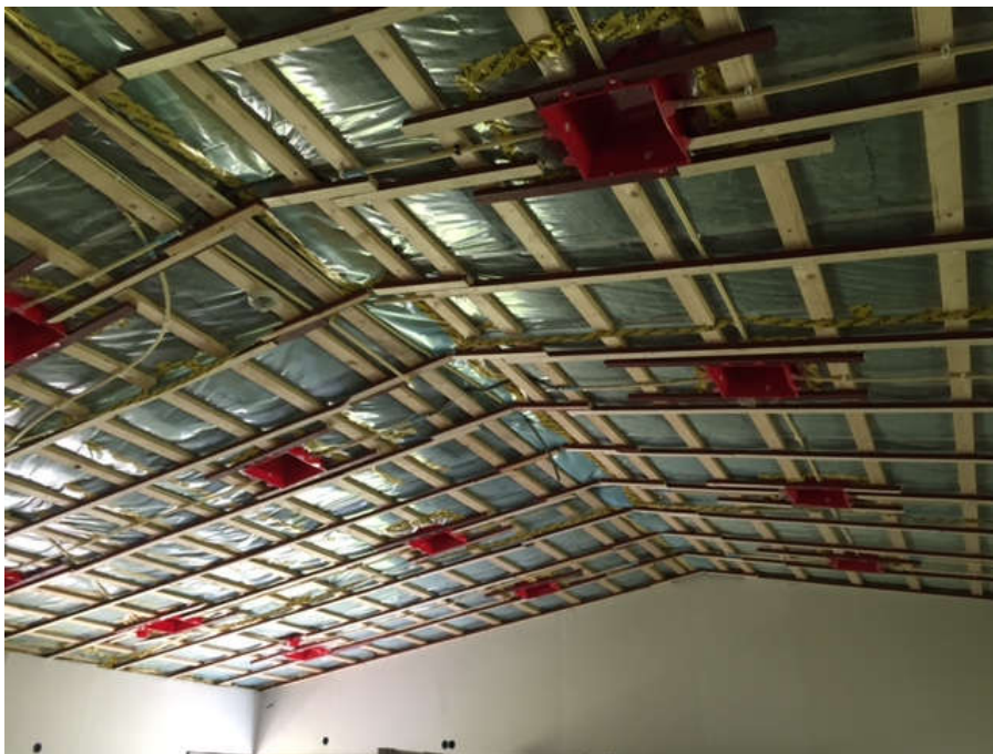
2015-06-07. All el och burkar för belysning på plats i storstugan. Nu väntar takpanel!
