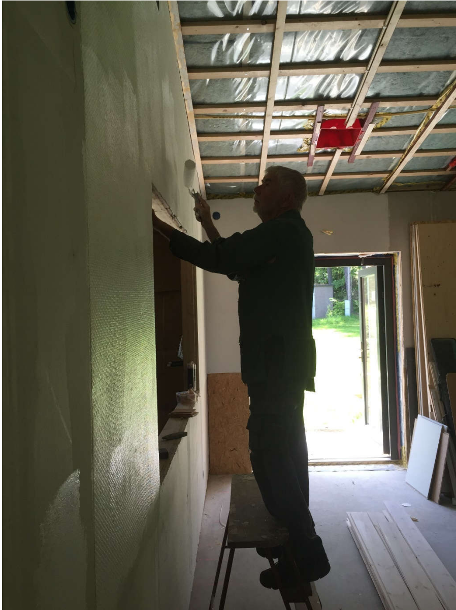
2015-06-09. Bosse målar storstugans vägg mot köket. Övriga väggar är nästan färdigmålade!
