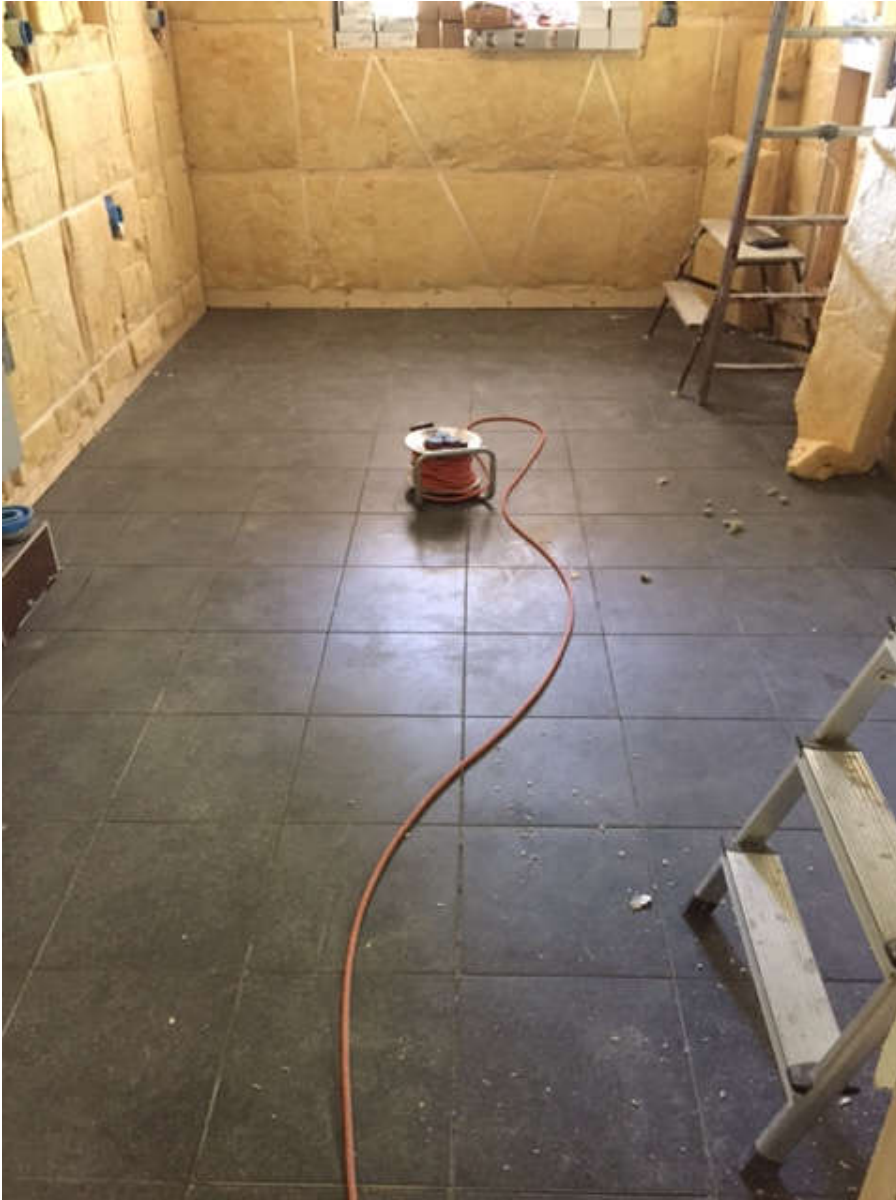
2015-06-07. Golvet lagt i köket, fogat och klart så Hans kan påbörja montering av skåp.
