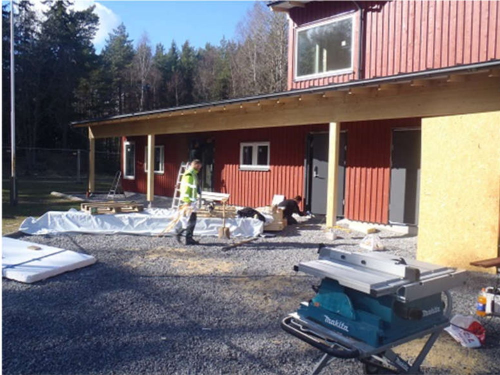
2014-03-23. WWL på plats igen. Denna gång på blixervisit men monterade samtliga ytterdörrar och fönster. Nu är skalet tätt!
