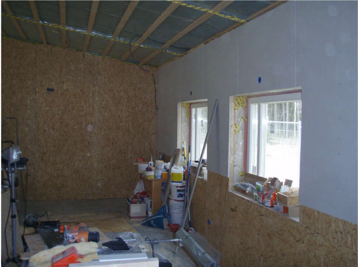
015-04-08. Klart med eldragning på norra och västra väggen så nu har B-O och kompani påbörjat täckning av väggarna
