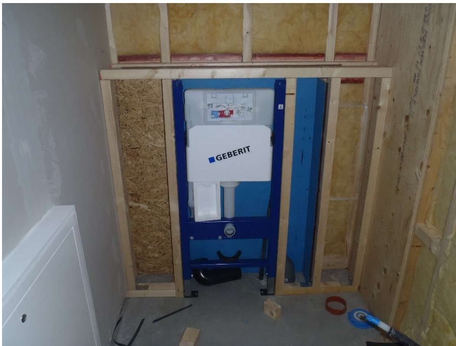
2014-09-24. Monteringen av toaletterna i omklädningsrummen går vidare
