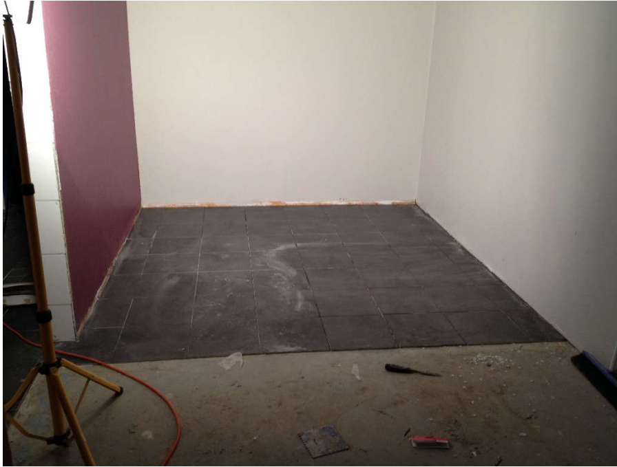
2014-10-17. Östra delen av damernas omklädningsrum färdigklinkrad
