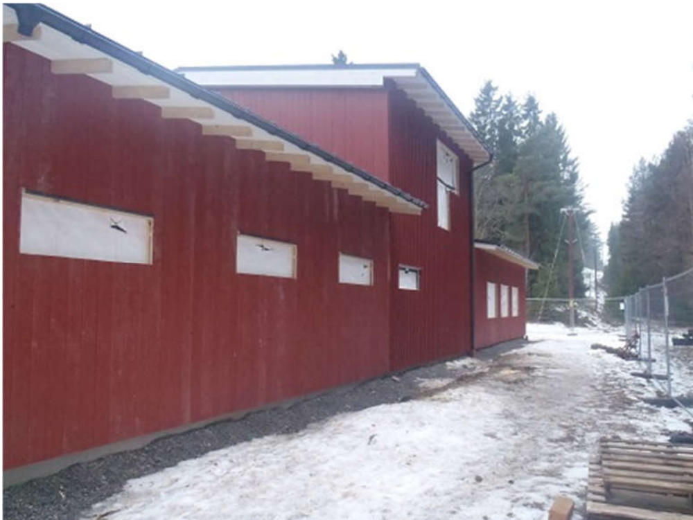
2014-02-04. Baksidan västerut. Lockpanelen på plats på högre delen innan byggställningen monterades ner. Notera också att stupröret är på plats. Övriga stuprör väntar på att lockpanelen ska komma på plats.
