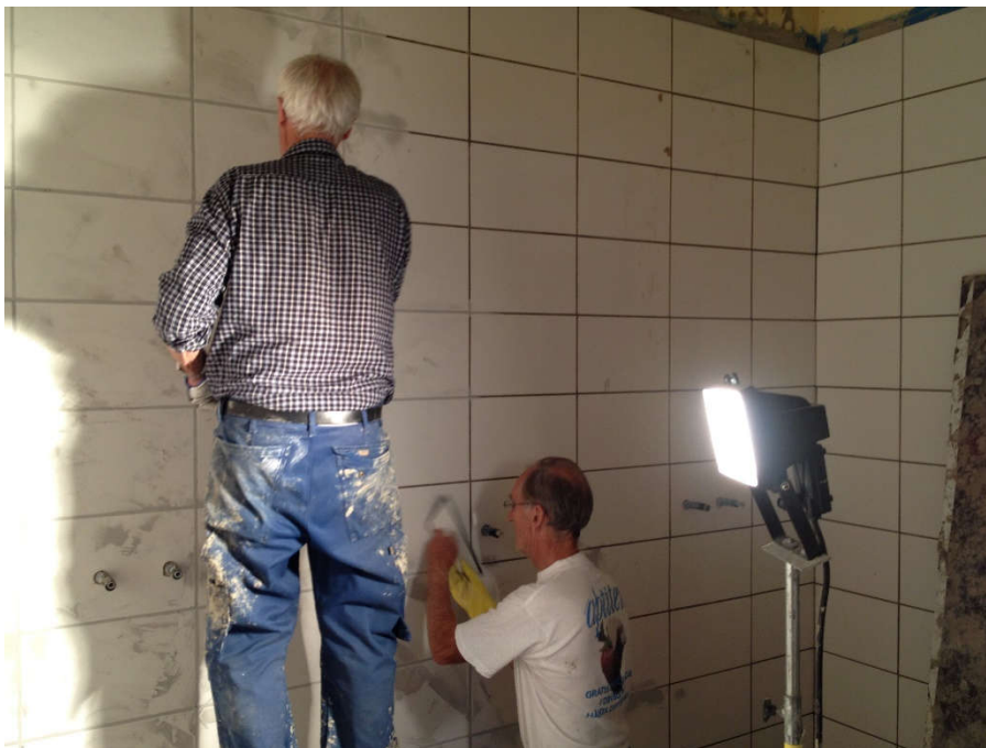
2014-09-10. Fogning av kakel har startat. Här är Ulf och B-O i full gång med detta i damernas duschutrymme. Fogen blir lite ljusgrå.
