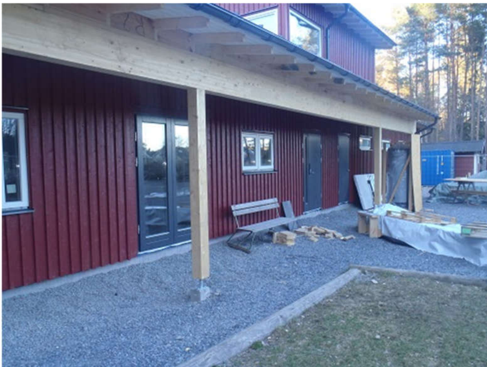
2014-03-23. Alla dörrar på framsidan. Fortfarande fel färg på den franska dubbeldörren som ska vara vit. Den ska dock målas om av WWL innan man är klar med den. //Vi ändrade oss senare och behåller den grå färgen på denna dörr//
