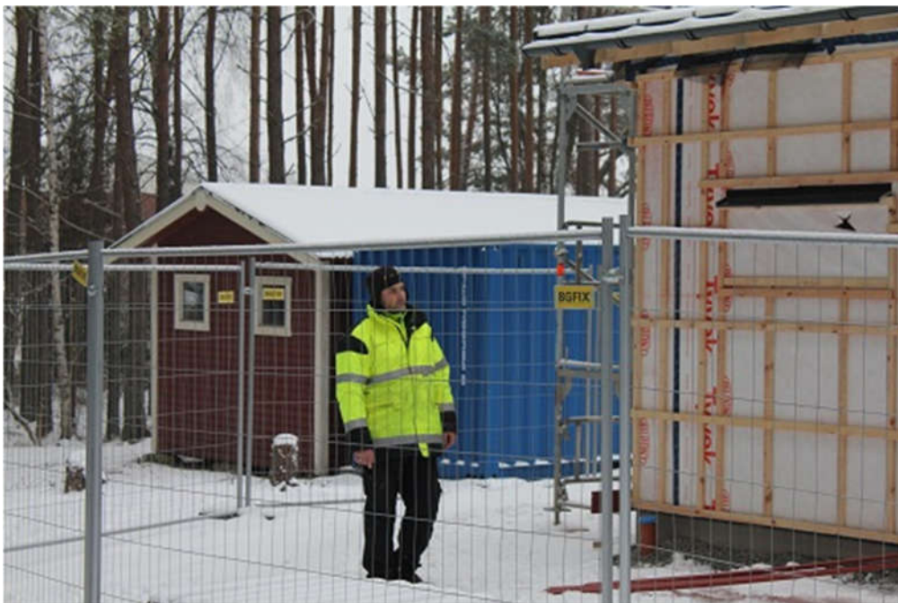
2014-02-01. WWL's bygglédare på plats
