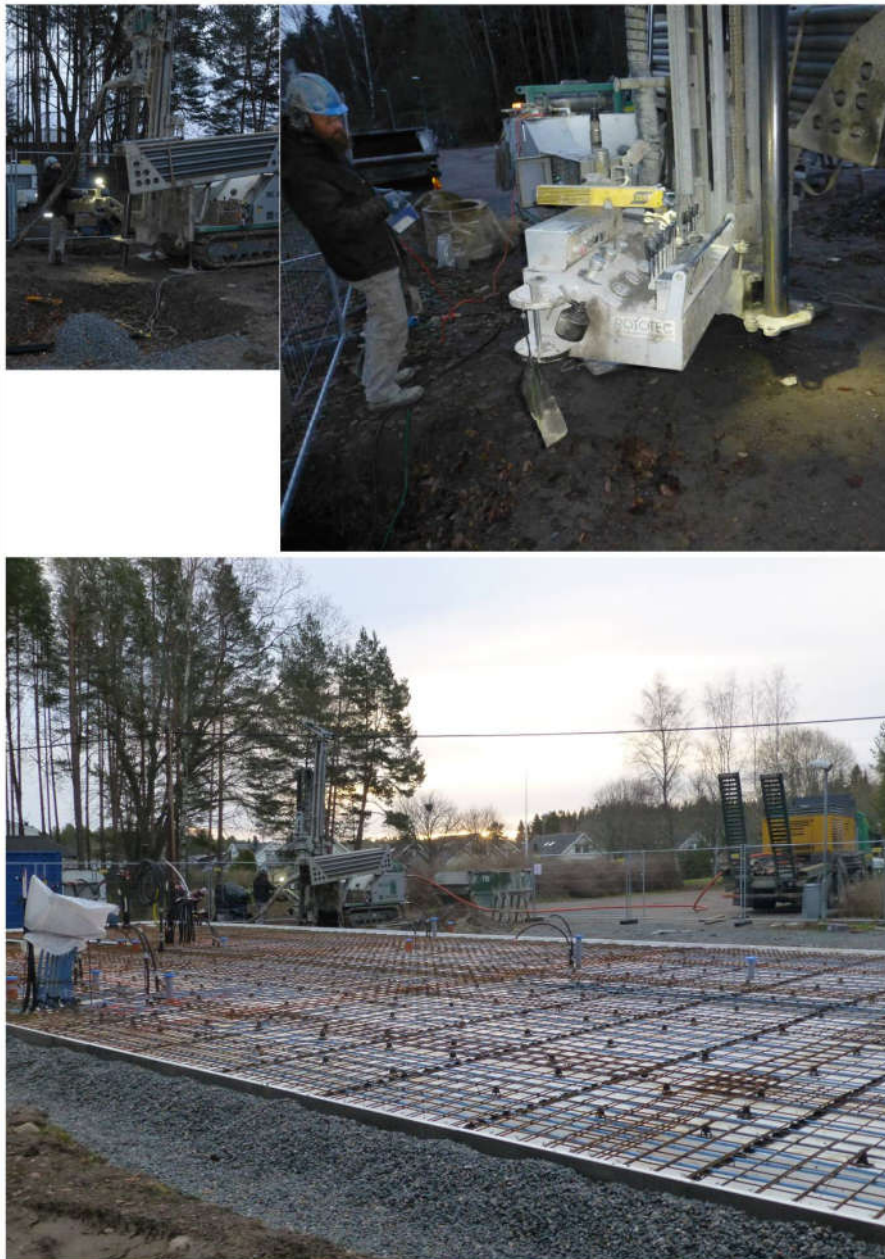
2013-11-18. I gryningen startar borrhningen av två 150 m djupa hål för bergvärme. Kl. 18 är allt klart! Borren gör 45 m i timmen i berg.
