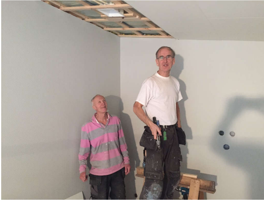
2015-01-02. Uffe och B-O monterar takskivor i mötesrummet på övervåningen. Även här börjar vi bli klara!
