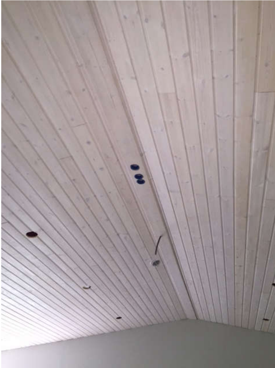
2015-07-14. Sista brädan i taket på storstugan på plats. Uttag för el till projektor, nätverk och högtalare samt brandlarm kan ses
