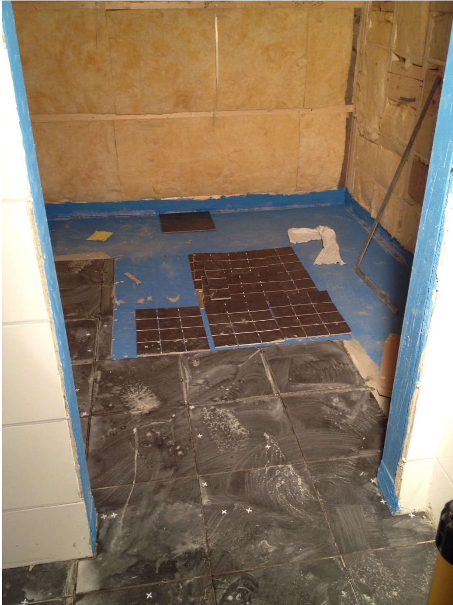
2014-10-17. Nu har klinkersättningen kommit igång. Här ser vi en vy från damernas dusch in i dambastun
