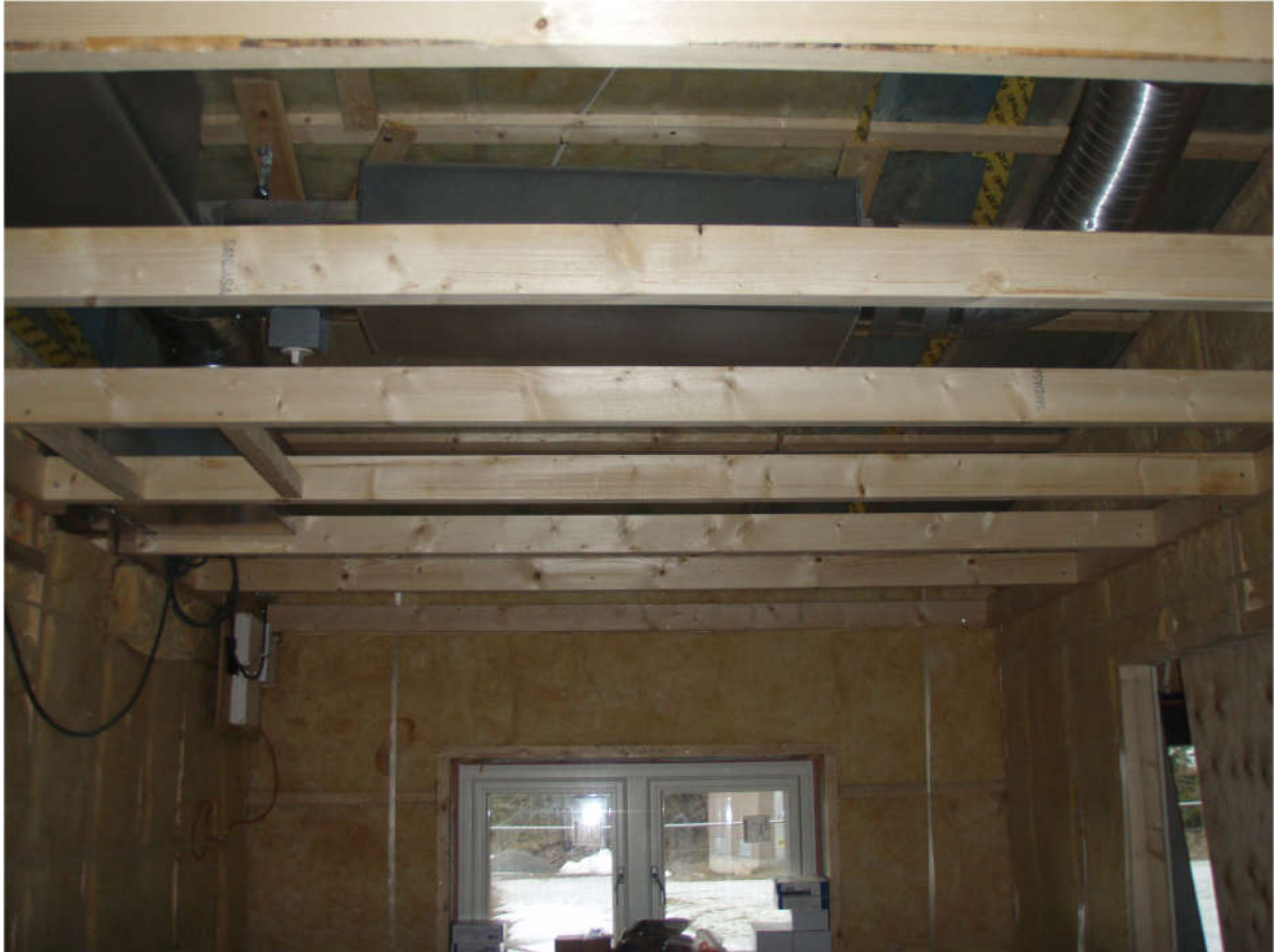
2015-03-02. Nu börjar vi så smått i storstugan och köket. Här ser vi takregling i köket
