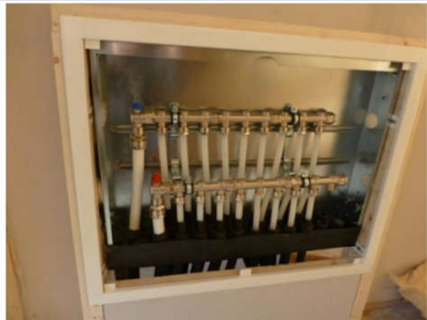
Fördelarna för kall- och varmvatten för hela huset sitter i toaletterna i herrarnas (vänstra bilden) och damernas (högra bilden) omklädningsrum. De kommer att döljas av en vitmaljerad lucka.
